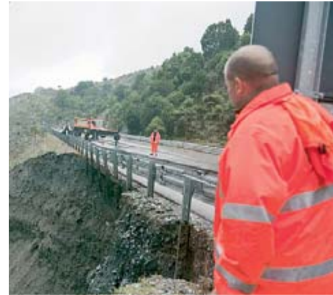
Operai dell'Anas al lavoro sulla Nuoro-Lanusei
