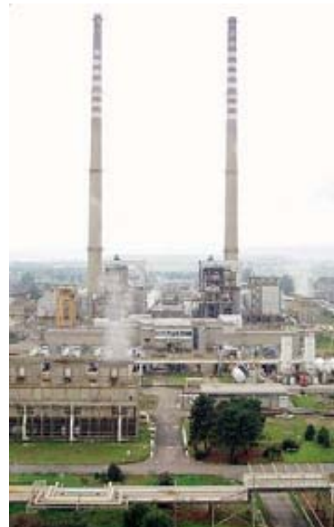
La centrale elettrica di Ottana
