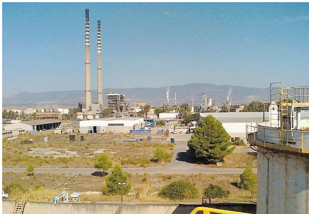
La Centrale elettrica e gli impianti ex Enichem di Ottana. A destra, il patron Paolo Clivati
