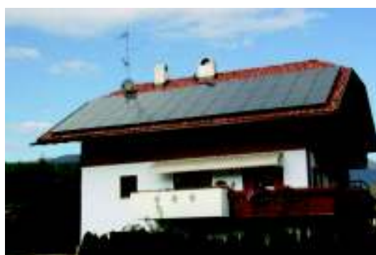
Figura 7 – Esempio di installazione idonea alla classificazione dell'impianto fotovoltaico nella categoria "su edifici" in caso di installazione complanare su un tetto a falda
