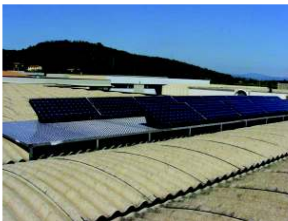
Figura 17 - Esempio di installazione non idonea alla classificazione dell'impianto fotovoltaico nella categoria "su edifici" – Motivazione: i moduli fotovoltaici non sono appoggiati alla superficie di copertura.
