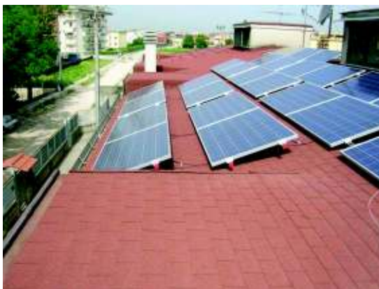
Figura 9 - Esempio di installazione non idonea alla classificazione dell'impianto fotovoltaico nella categoria "su edifici" – Motivazione: i moduli non sono complanari alla falda di copertura
