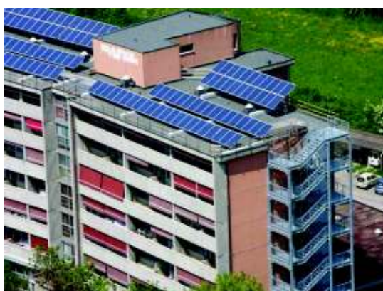
Figura 5 - Esempio di installazione non idonea alla classificazione dell'impianto fotovoltaico nella categoria "su edifici" – Motivazione: l'elemento perimetrale non può essere considerato balastra e la quota massima dei moduli supera i 30 cm
