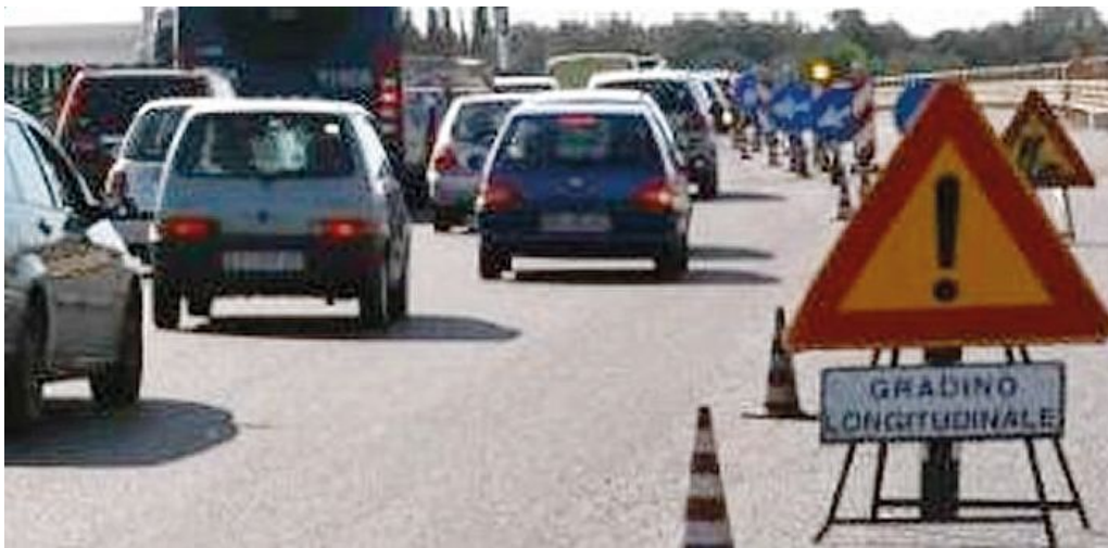
Un tratto della 131 Dcn dove sono in corso i lavori da parte dell'Anas (foto Sedda)
