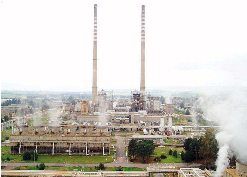
Una veduta della zona industriale di Ottana
