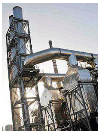
La centrale elettrica
