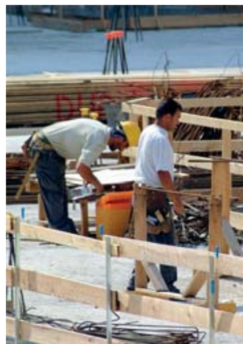
Un cantiere edile in Sardegna
